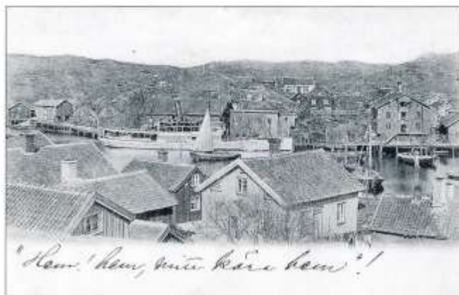
Ångaren LSN331, runt seheljefet vid den äldsta ångbåtsbyggnaden vid konservfabriken på östra sidan i Grundsunds hamn. Marstrandsholagets nya brygga kom att ligga strax utanför bildens högerkant. Vykort
